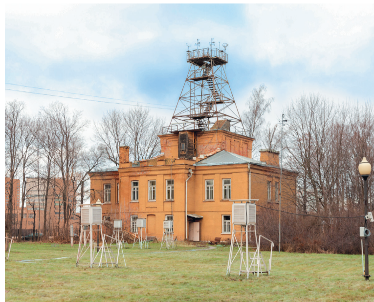
Здание метеообсерватории, построенное в 1912 году
