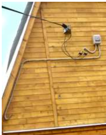
Рисунок 2 – Ввод проводов в здание
