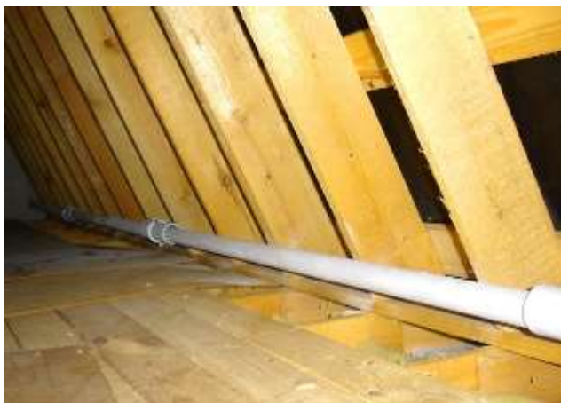
Рисунок 3 – Ввод проводов в здание
