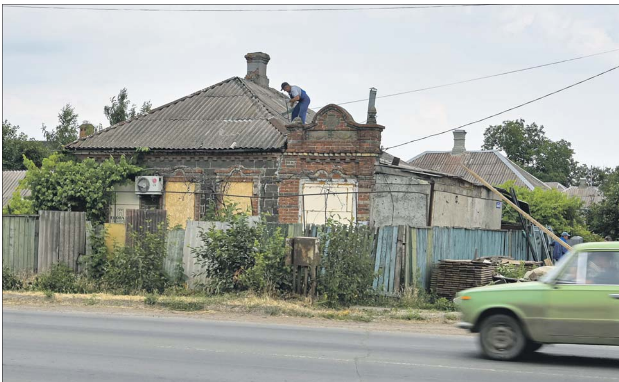
Добровольцы помогают с ремонтом домов инвалидов, пожилых, семей с детьми
